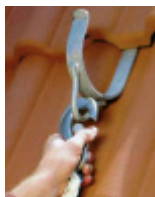
DIN EN 517 Sicherheitsdachhaken (Bild: Bau-BG)
