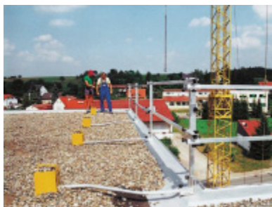
Absturzsicherung auf dem Flachdach
